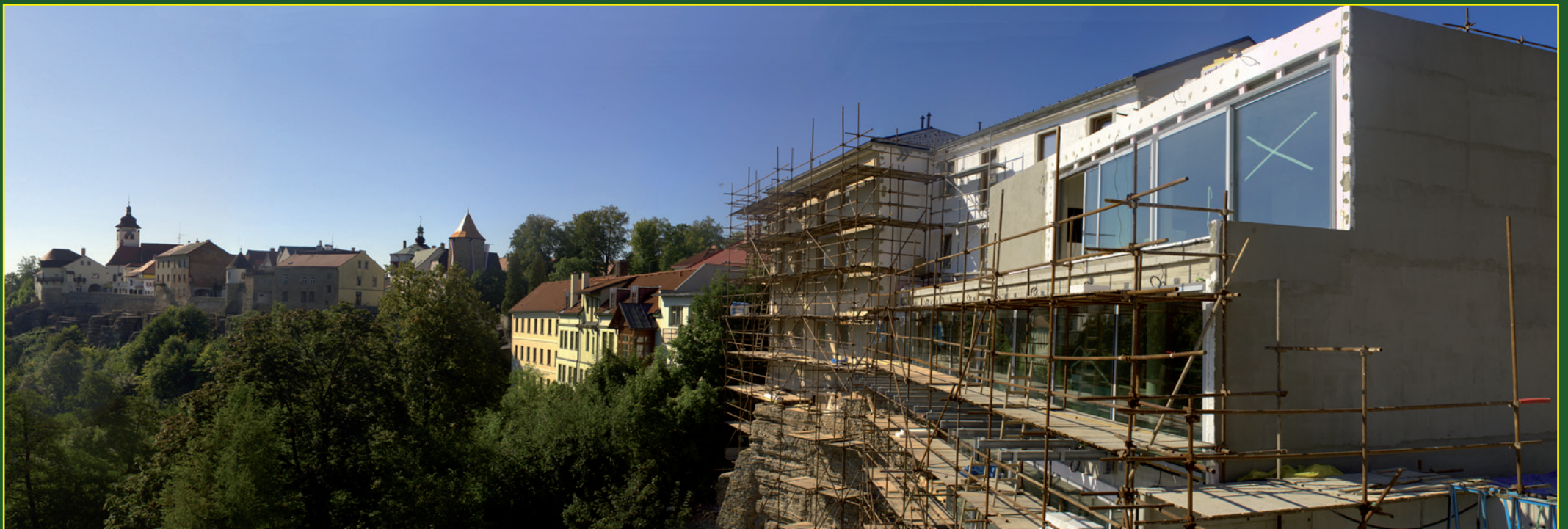
Objekt „Rajská zahrada“ - zadní část, v Novém Městě nad Metují - před dokončením. Foto: J.B.
